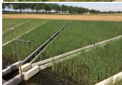
Retentionsbodenfilter plus auf der Kläranlage Rheinbach des Erftverbands (Foto: Erftverband, Kläranlage Rheinbach)
