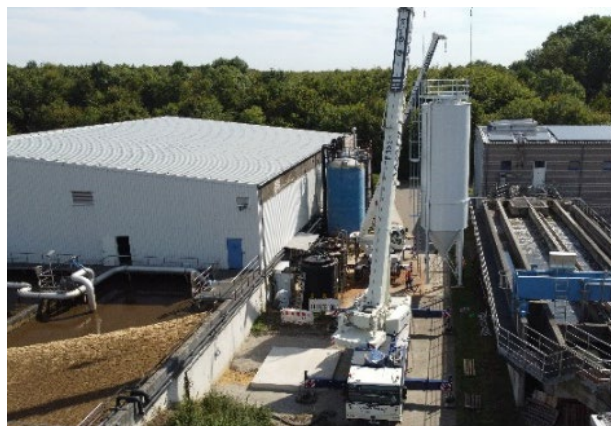
Errichtung PAK-Silo auf der Kläranlage Kaarst-Nordkanal, Erftverband (Foto: Erftverband)
