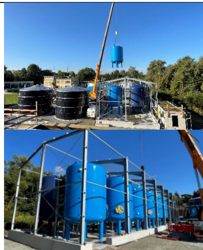
Bau der GAK-Kesselhalle auf der Kläranlage Gütersloh Putzhagen, Stadt Gütersloh (Foto: Hydro-Ingenieure GmbH)
